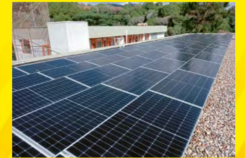
Sostre de l'edifici de Primària
